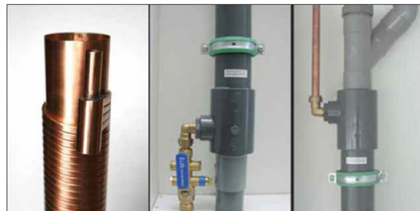
Vertikale passive gjenvinnere: PowerPipe fra Renewability og DoucheBooster fra Bries
